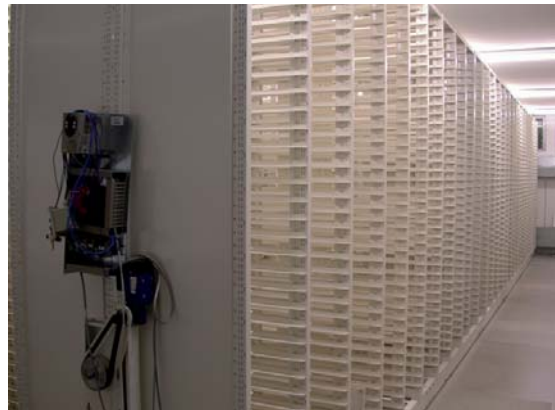
Neue Kompaktanlage während der Einräumarbeiten.
