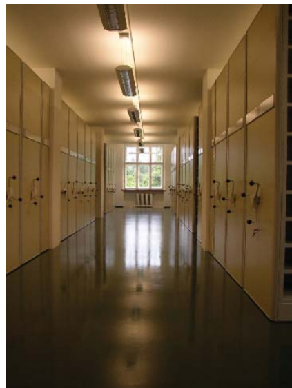
Die neu eingebaute Kompaktanlage des Münchner Herbars.
